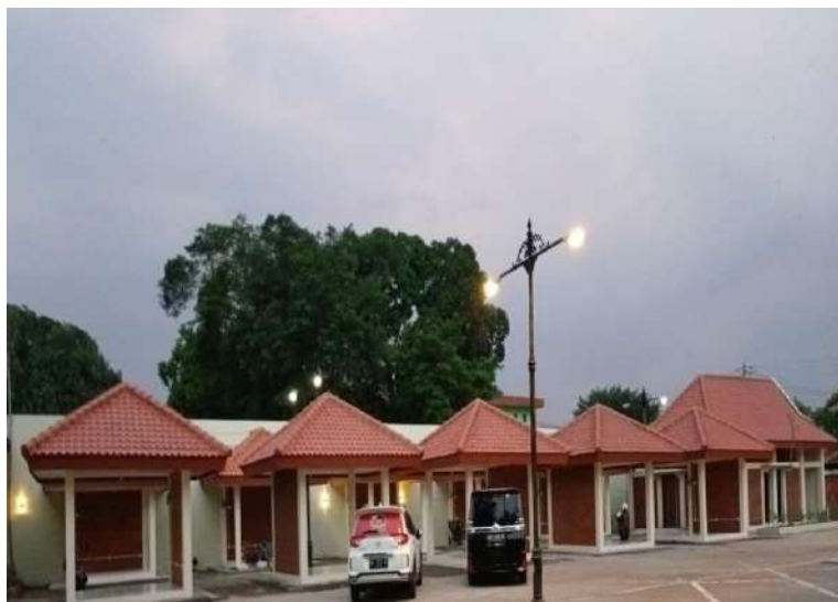
Gambar 4.3 Pembangunan Kios Souvenir nDalem Djojokoesoeman
