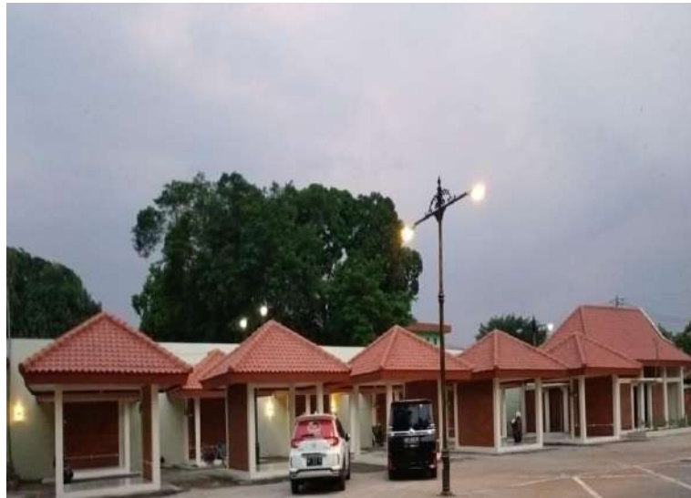
Gambar 3.11 Pembangunan Kios Souvenir nDalem Djojokoesoeman
