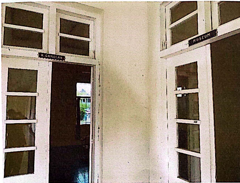
Foto 14. Pintu Masuk Ruang Gamelan Bangunan Utama
