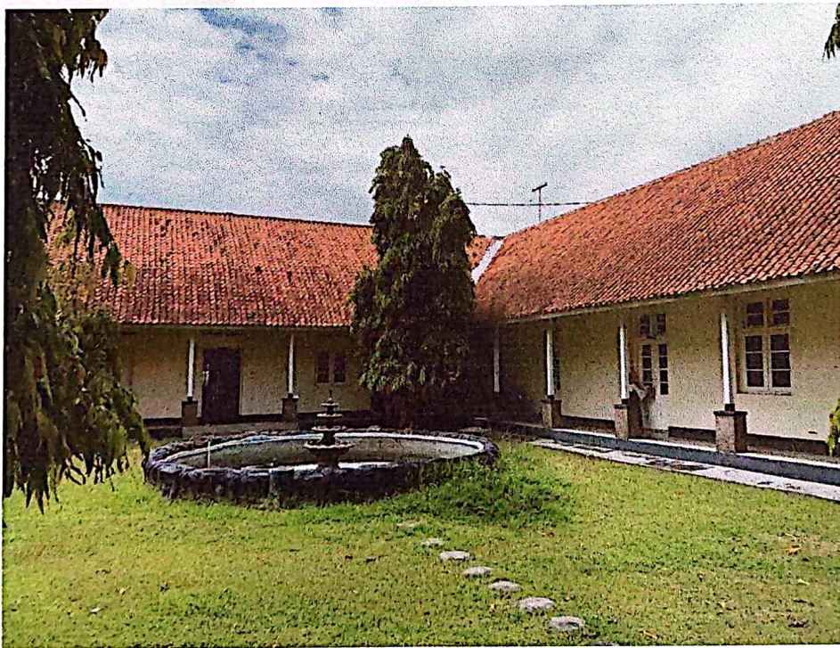
Foto 3. Taman Bagian Dalam Bangunan Utama
