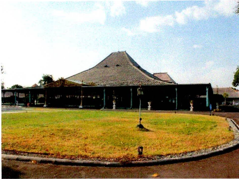
Foto 1. Bangunan Inti Pura Mangkunegaran
