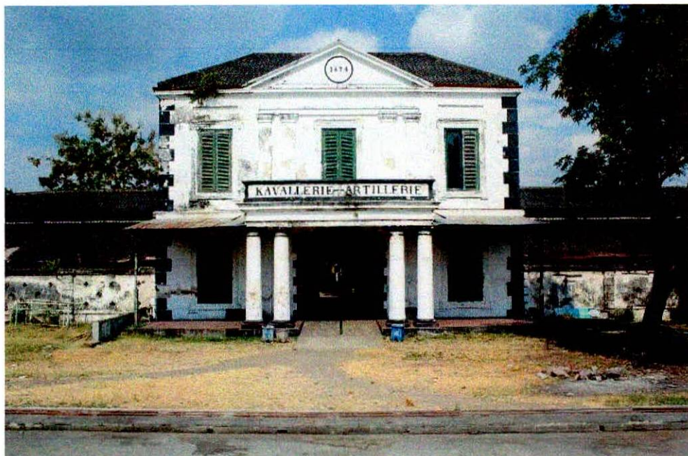
Foto 4. Bangunan Kavallerie-Artillerie Menghadap Barat
