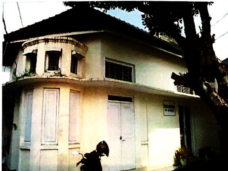
Foto 5. Bangunan Sisi Timur Yang Masih Asli Digunakan Sebagai Pos Penjagaan
