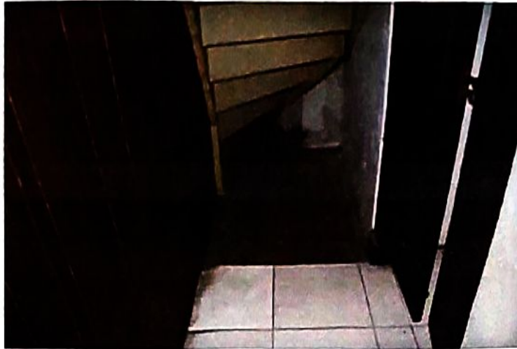
Foto 9 Tampak Tegel Asli Dibawah Tangga
