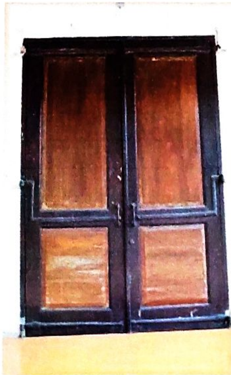
Foto 10 Pintu Depan Utama
