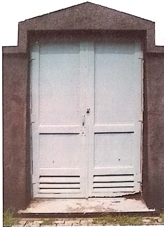
Foto 5. Tampak Pintu Berdaun Ganda Terbuat Dari Plat Besi
