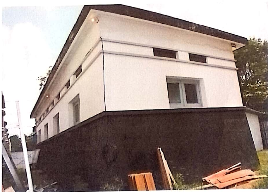
Foto 4. Bangunan Gardu Listrik Tampak Samping Selatan Dengan Jendela Kaca ( bovenlicht )
