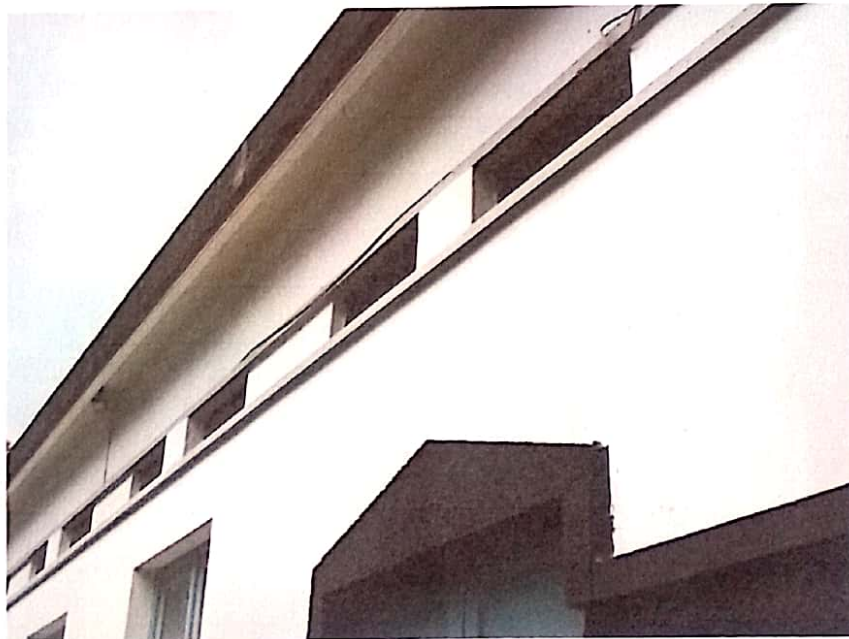
Foto 6. Lubang Sirkulasi Udara Berbentuk Persegi Panjang Di Bagian Atas Bangunan
