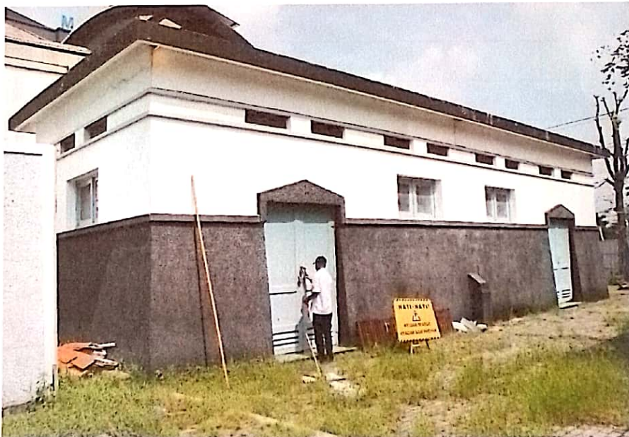
Foto 2. Bangunan Gardu Listrik Tampak Kiri Depan Sisi Selatan
