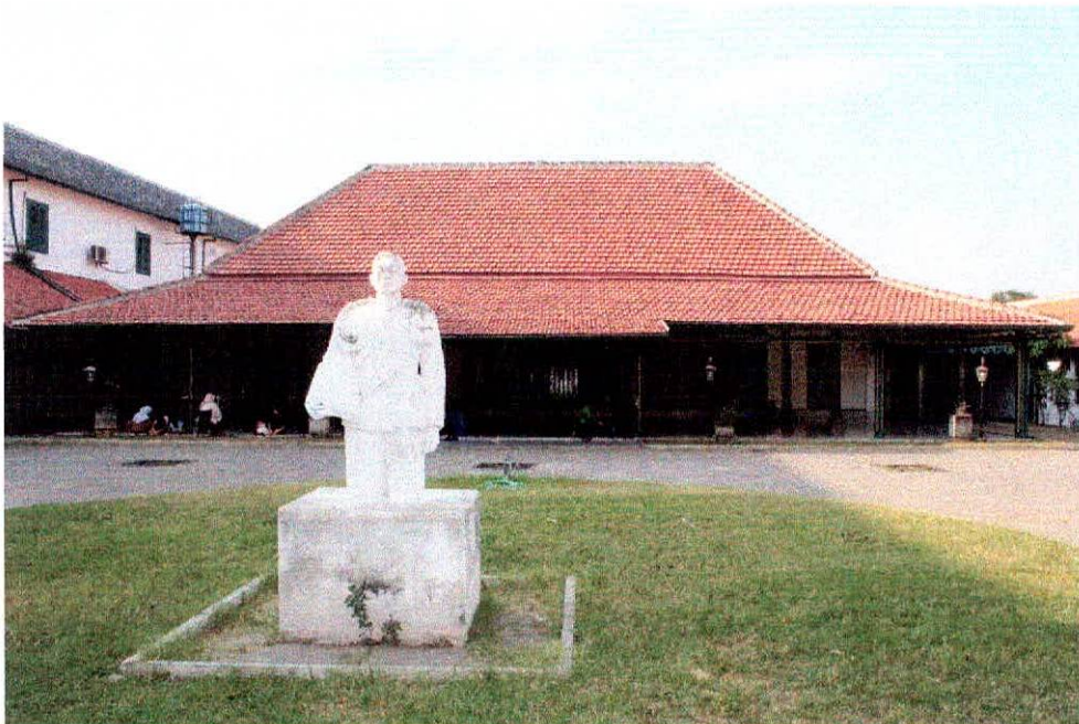
Foto 1. Bangunan Dalem Prangwedanan Tampak Depan Menghadap Selatan
