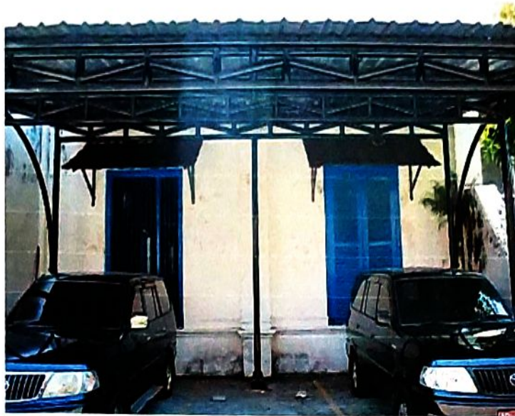
Foto 5. Tampak Luar Samping Selatan Ruang Pemotongan Hewan Sapi
