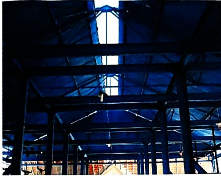
Foto 7. Tampak Struktur Atas Ruang Rumah Pemotongan Hewan Sapi
