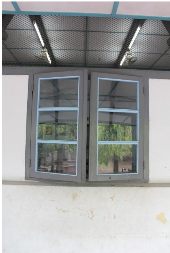
Jendela dan Lubang Angin Ruang Kelas Sumber: Dinas Kebudayaan Kota Surakarta, 2021
