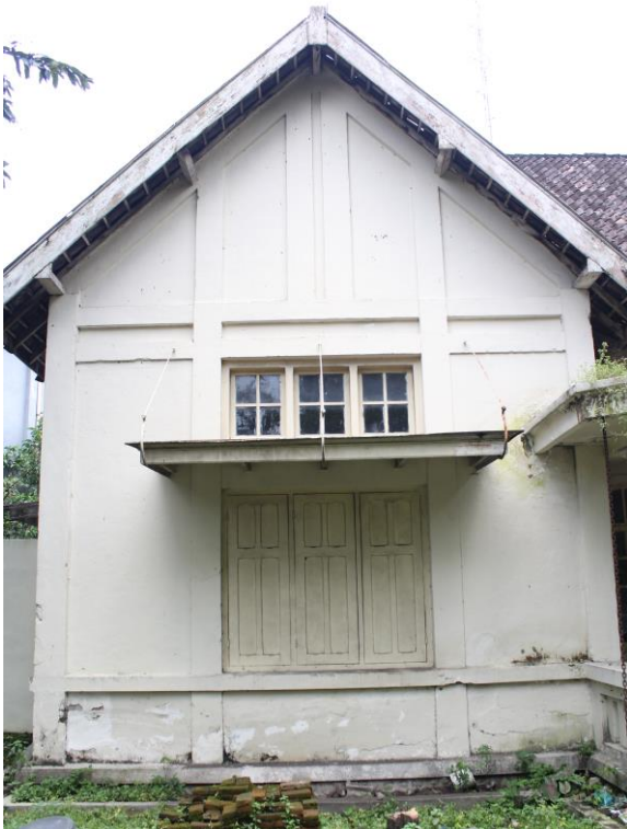
Gable pada muka Bangunan Ibu Ani
