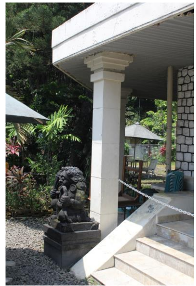
Kolom pada teras rumah Sumber: Dinas Kebudayaan Kota Surakarta, 2021
