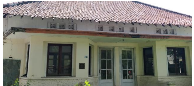
Bagian Jendela dan Lubang Angin Bangunan Sumber: Dinas Kebudayaan Kota Surakarta, 2021
